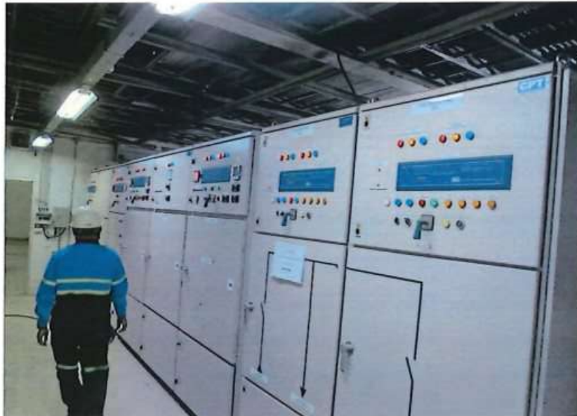
ตรวจสอบตู้ Main Distribution Board
