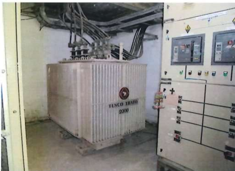
ตรวจสอบตู้ Main Distribution Board
